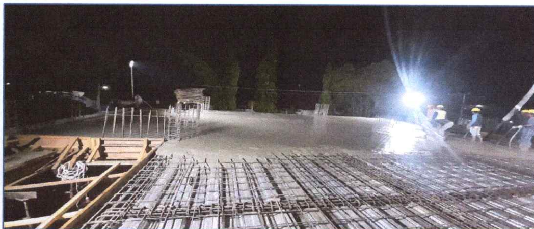
PEKERJAAN PEMBESIAN PLAT LANTAI 2 GEDUNG UTAMA
