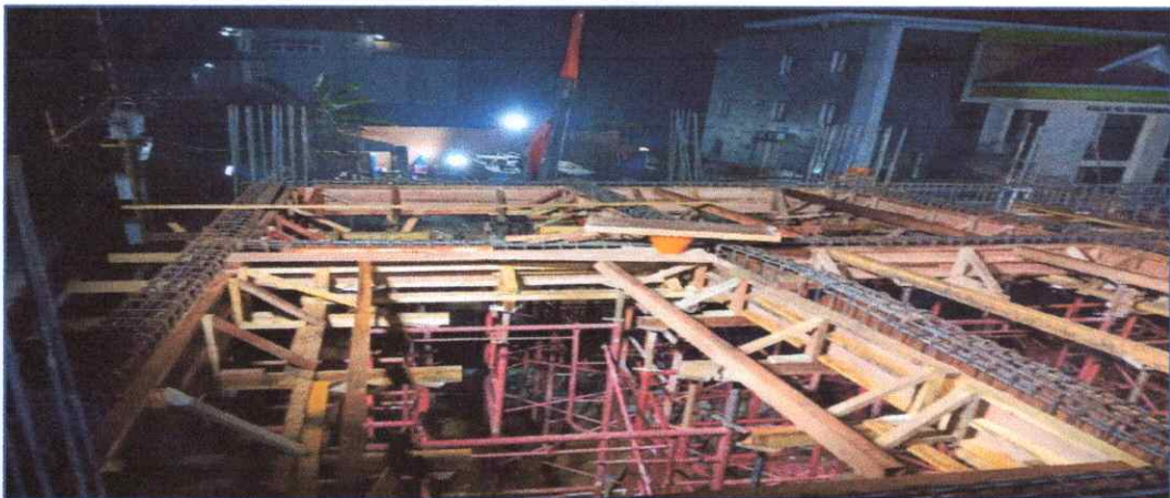
PEKERJAAN PEMESIAN BALOK LT 2 GEDUNG UTAMA
