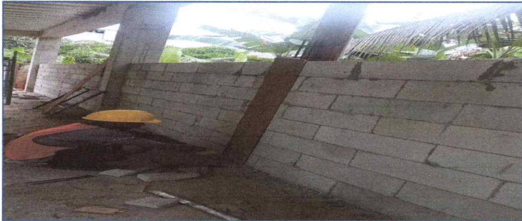
PEMASANGAN DINDING BATA RINGAN R. GENSET
