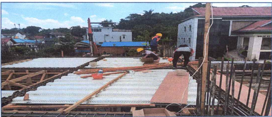
PEMASANGAN BEKISTING FLOOR DEK PLAT LT 2 GEDUNG UTAMA
