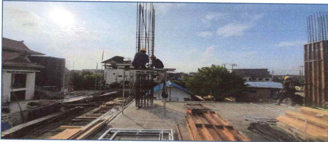
PEKERJAAN PEMBESIAN KOLOM LT2 KE LT 3 GEDUNG UTAMA
