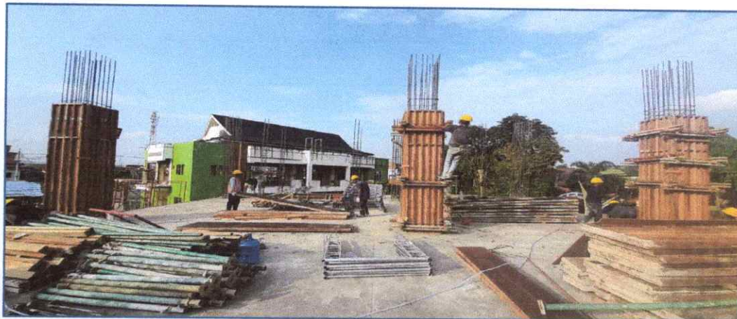
PEKERJAAN BEKISTING KOLOM LT 2 KE 3 GEDUNG UTAMA
