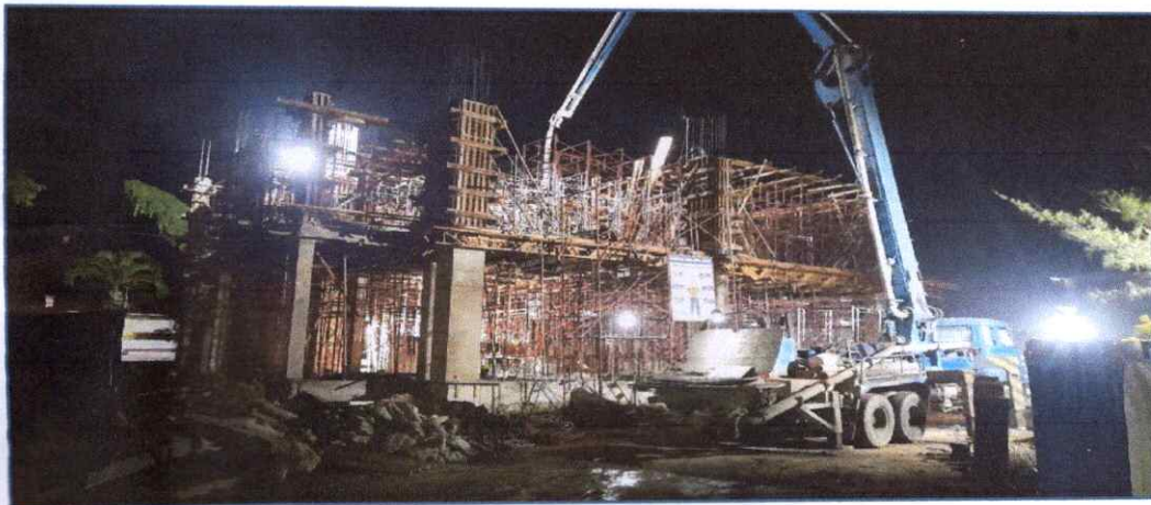
PEKERJAAN PENGEORAN KOLOM LT2 KE LT 3 GEDUNG UTAMA
