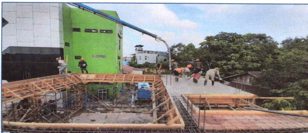
PEKERJAAN PENGECORAN PLAT DAK ATAP R. GENSET
