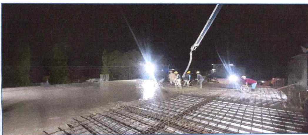
PEKERJAAN PENGECORAN PLAT LANTAI 2 GEDUNG UTAMA
