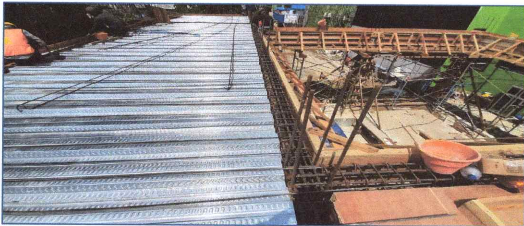
PEKERJAAN PEMBESIAN DAN BEKISTING BONDEK PLAT ATAP R.GENSET
