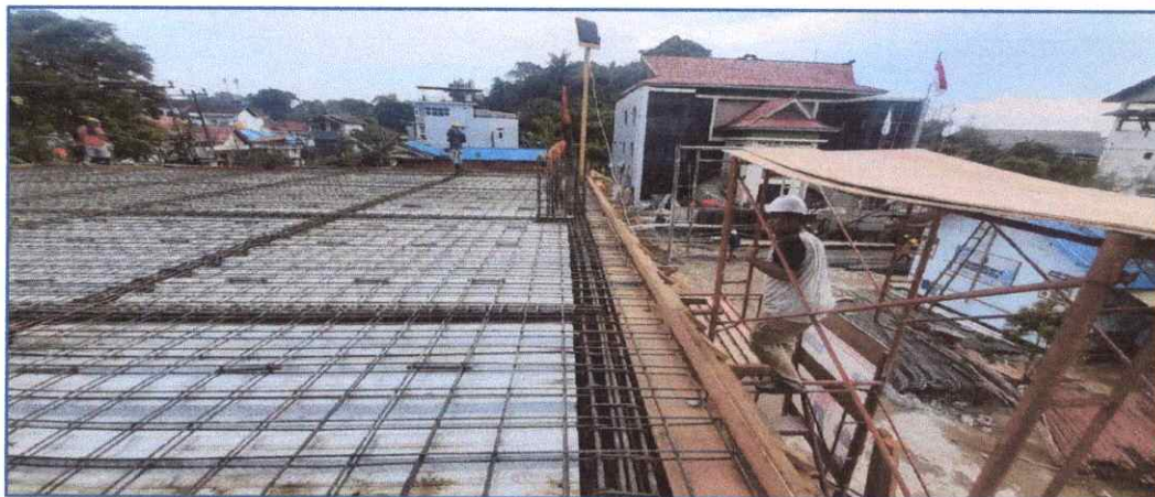
PEKERJAAN PEMBESIAN PLAT LANTAI 2 GEDUNG UTAMA
