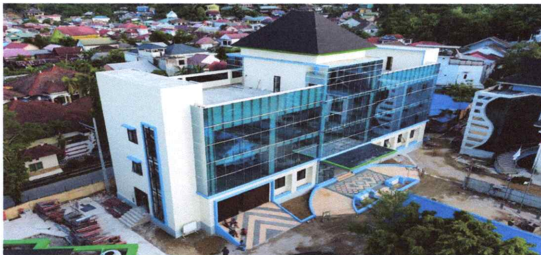
TAMPAK SAMPING BANGUNAN LAB K3
