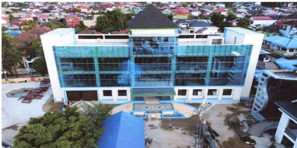
TAMPAK DEPAN BANGUNAN LAB K3
